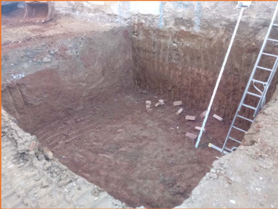
Foto 3. Foto final de l'excavació del fossat de la grua
