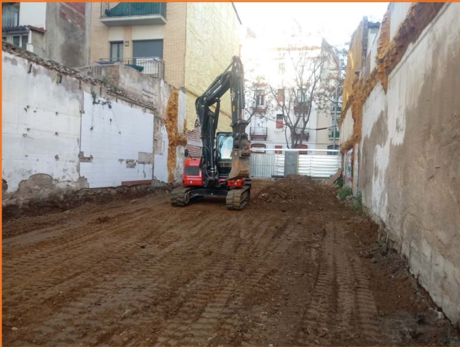
Foto 1. Foto inicial abans de l'inici dels rebaixos.
