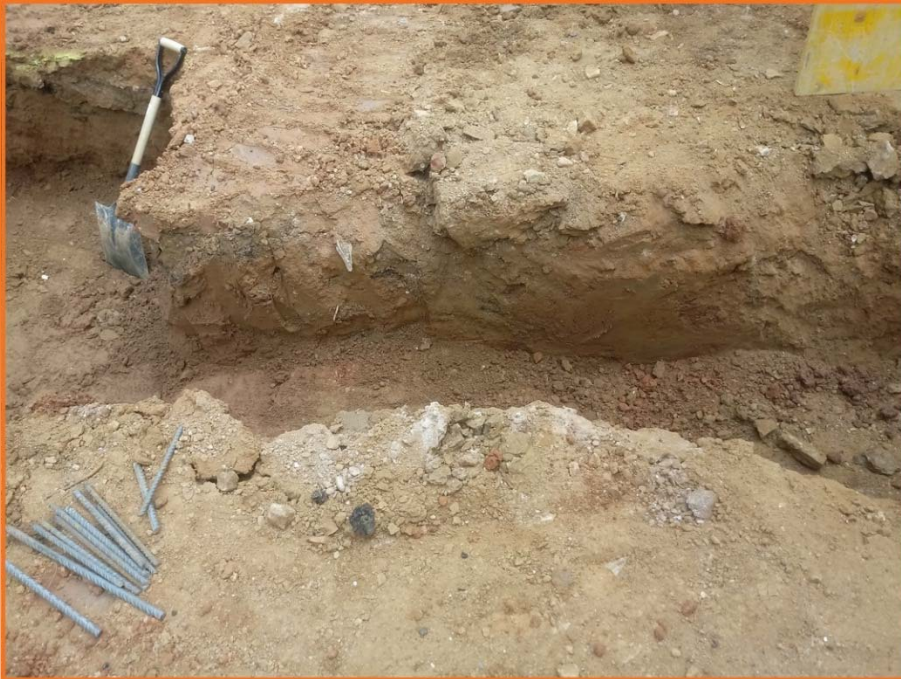
Foto 7. Foto final de la rasa 4
