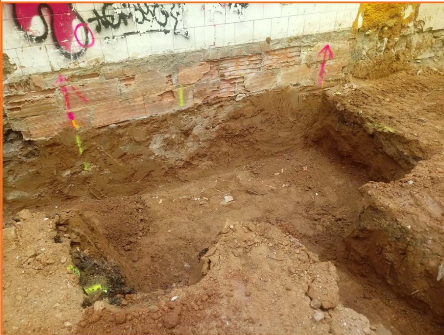
Foto 9. Foto final del fossat d'ascensor.
