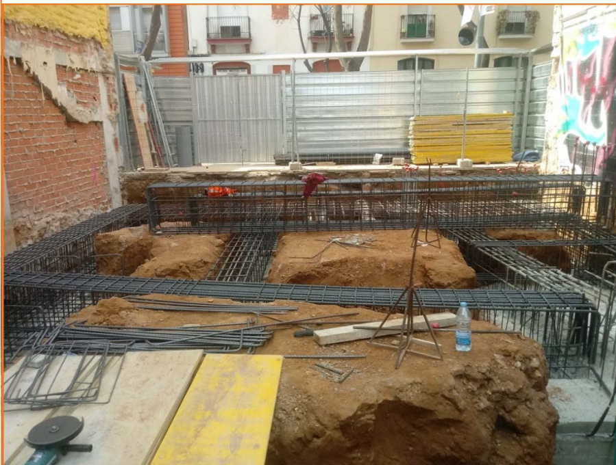
Foto 10. Foto final de l'entramat de rases per construir la fonamentació del nou edifici.
