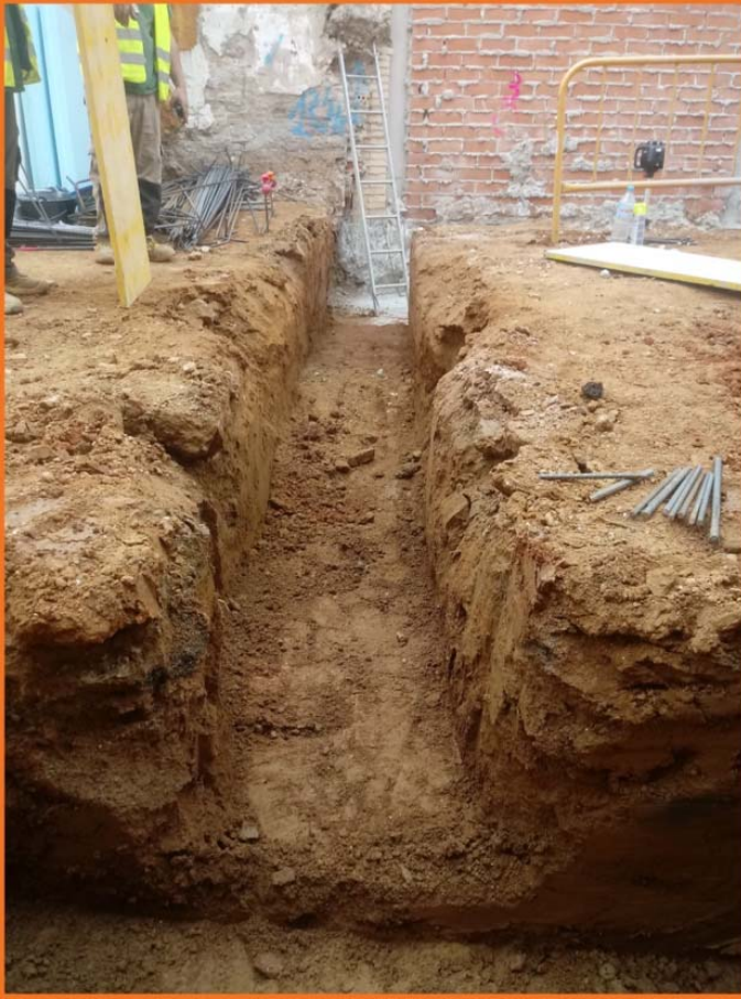
Foto 5. Foto final de la rasa 2.
