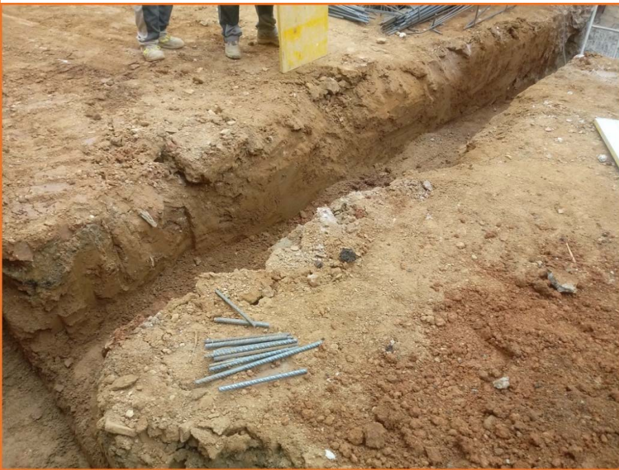
Foto 6. Foto final de la rasa 3.
